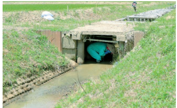
用水路の橋の下に避難する住民
